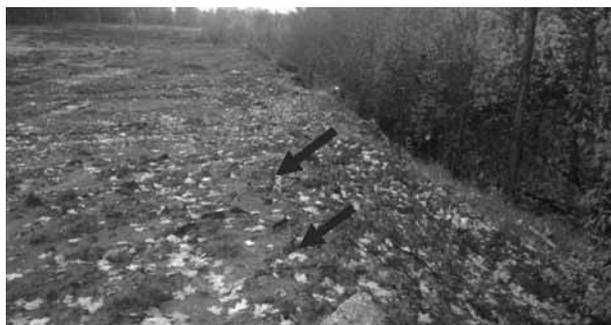
**Рис. 1.** Трещины закола на бровке откоса отвала
