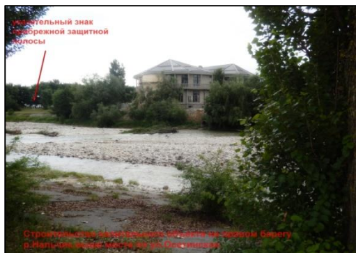
Рис. 2. Строительство объекта на правом берегу р. Нальчик
