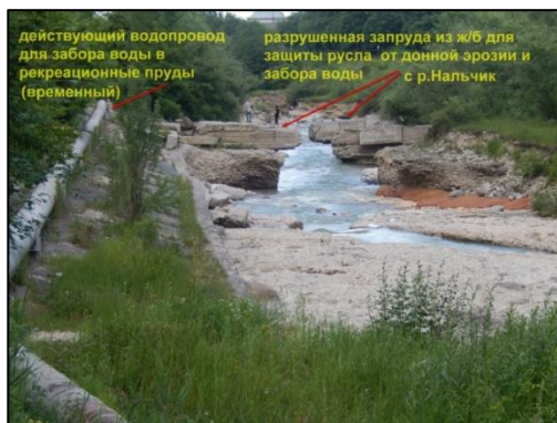
Рис. 8. Разрушенный запруд г. Нальчик
