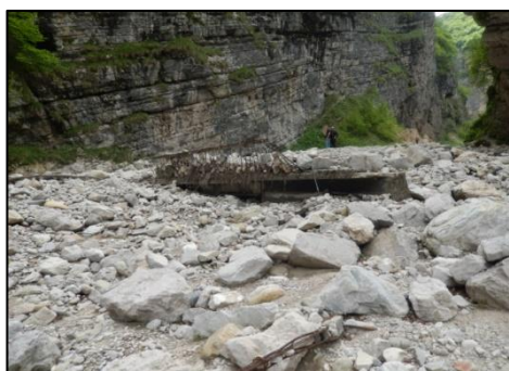
Рис. 6. Селевой поток по р. Псыгансу с разрушением моста и автодороги
