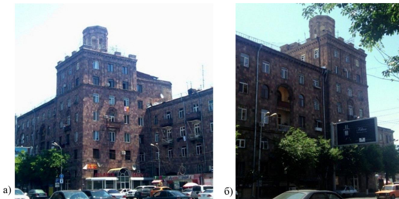
Рис. 1. Общий вид здания
