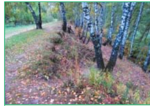
Рис. 4.4. Оползневые проявления между оврагами Гнилуша и М. Гнилуша
