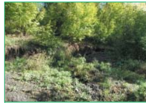
Рис. 4.5. Оползневые смещения вблизи пос. Годуново
