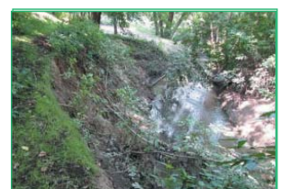
Рис. 4.14. Оползни в долине р. Котловки
