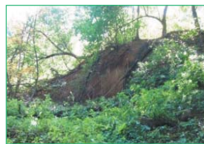
Рис. 4.6. Стенка срыва на оползневой террасе на участке Фили-Кунцево
