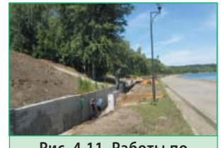
Рис. 4.11. Работы по инженерной защите территории на участке Коломенское
