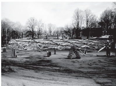
Рис. 3. Сборка покрытия на земле. (Фото автора 21.11.16)
