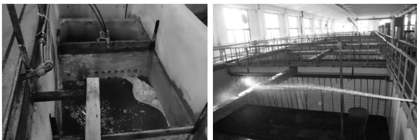
**Рис. 1.** Водопроводная очистная станция (слева направо): смеситель и скорый фильтр
