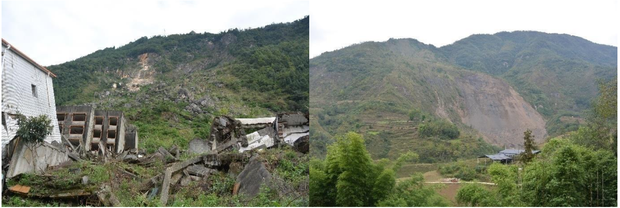
Рис. 3.14. Оползень Бэйчуанечжунсюе в уезде Бэйчуань, разрушивший новую школу (левый) и оползень Шуйцзинянь в уезде Чэньцзяба (правый) (фото автора 2016г.)
