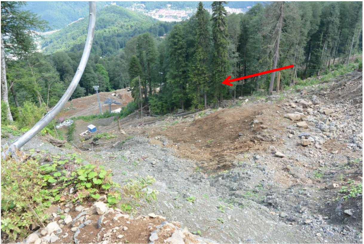
Рис. 4.1. Изучаемый оползень сформировался на территории, примыкающей к станции канатной дороги (фото автора).
