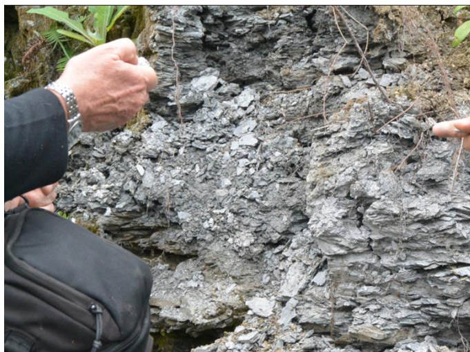
Рис. 5.7. Остальная оползневая зона представлена сланцами с высокой степенью выветрелости, что возможно оказывала существенное влияние на устойчивости склонов при землетрясении (фото автора 2016г.)
