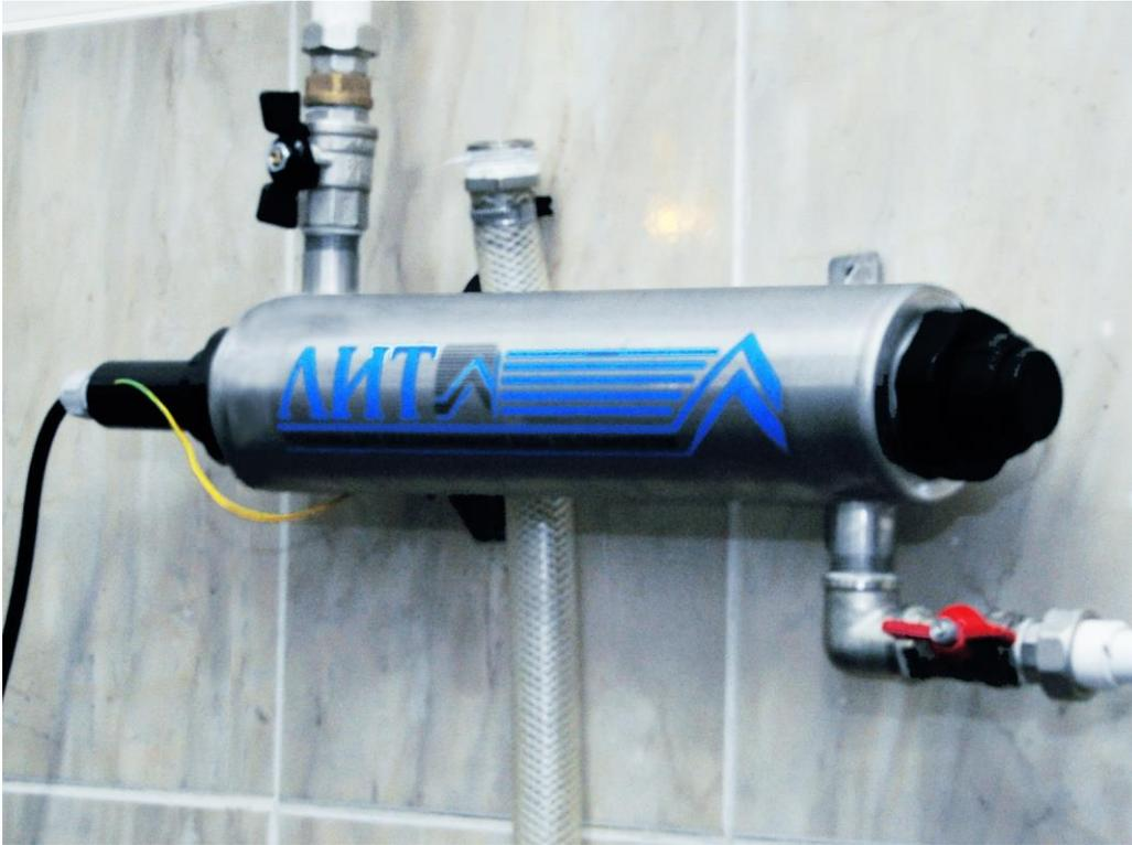
Фотография 19. УФ стерилизатор воды
