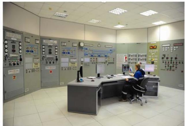
Рис. 3. Внешний вид мнемощита "Контур" и гибридной системы автоматизированного управления компрессорным цехом (САУ КЦ)
