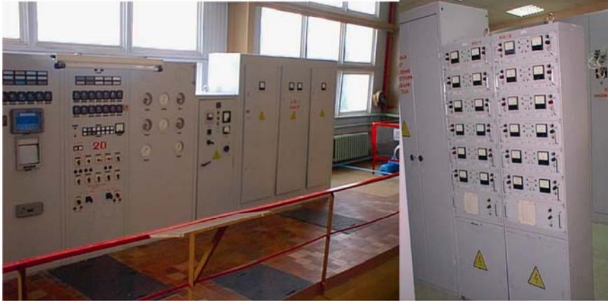
Рис. 1. Агрегатная система управления "Электра-1" и загазованности "Газ-1"
