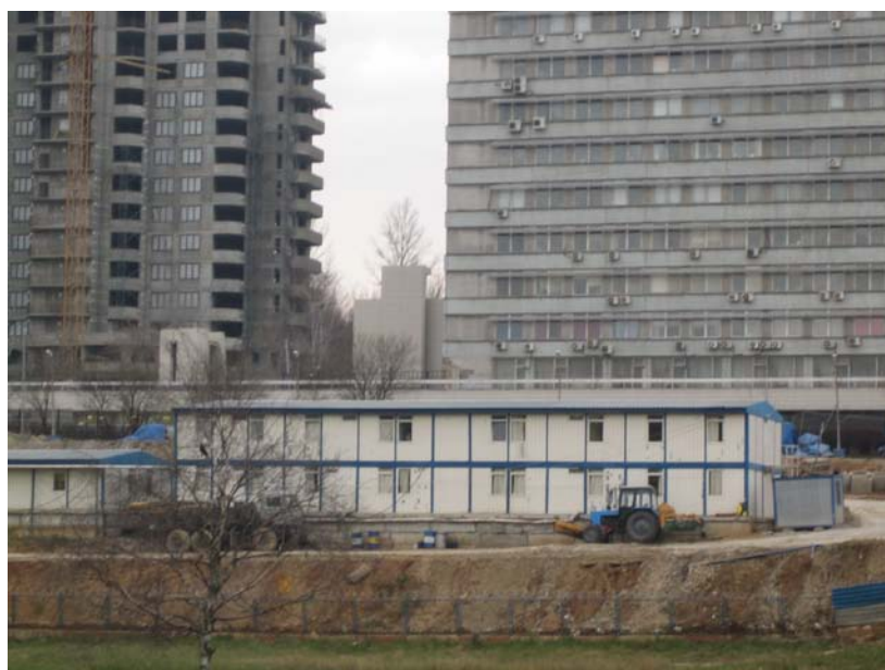
Рис. 2.3.5. Временное жилье для размещения рабочих-мигрантов на строительном объекте в Москве
