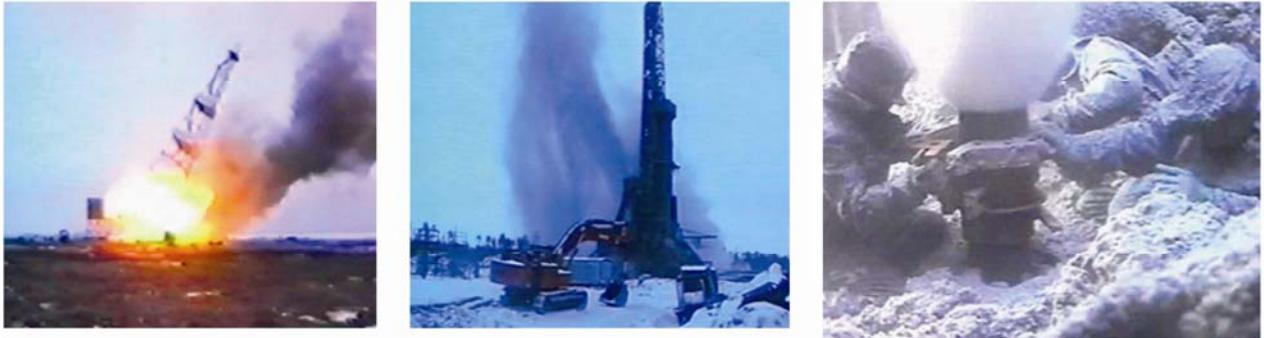
Рис. 4. Различные виды аварий при строительстве скважин
