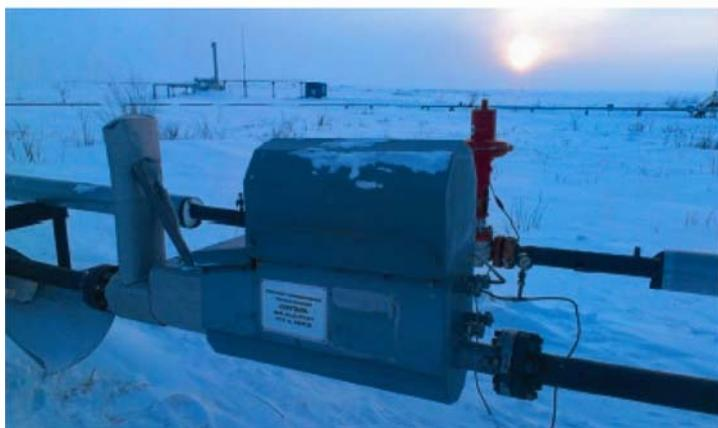
Рис. 6. Комплекс "Пингвин" для закачки газа в затрубье
