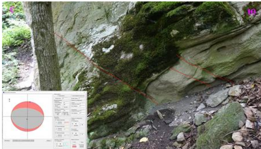
Рис. 2. Характер трещиноватости и стереограмма борозд скольжения в олигоценовых отложениях г. Развалка
