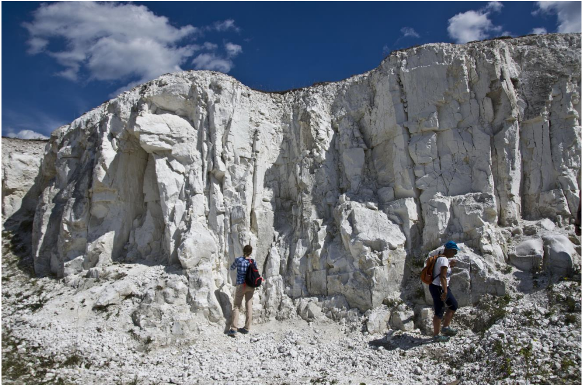
Рис. 6. Трещины в песч. мелу (верхний мел, сантонский ярус)
