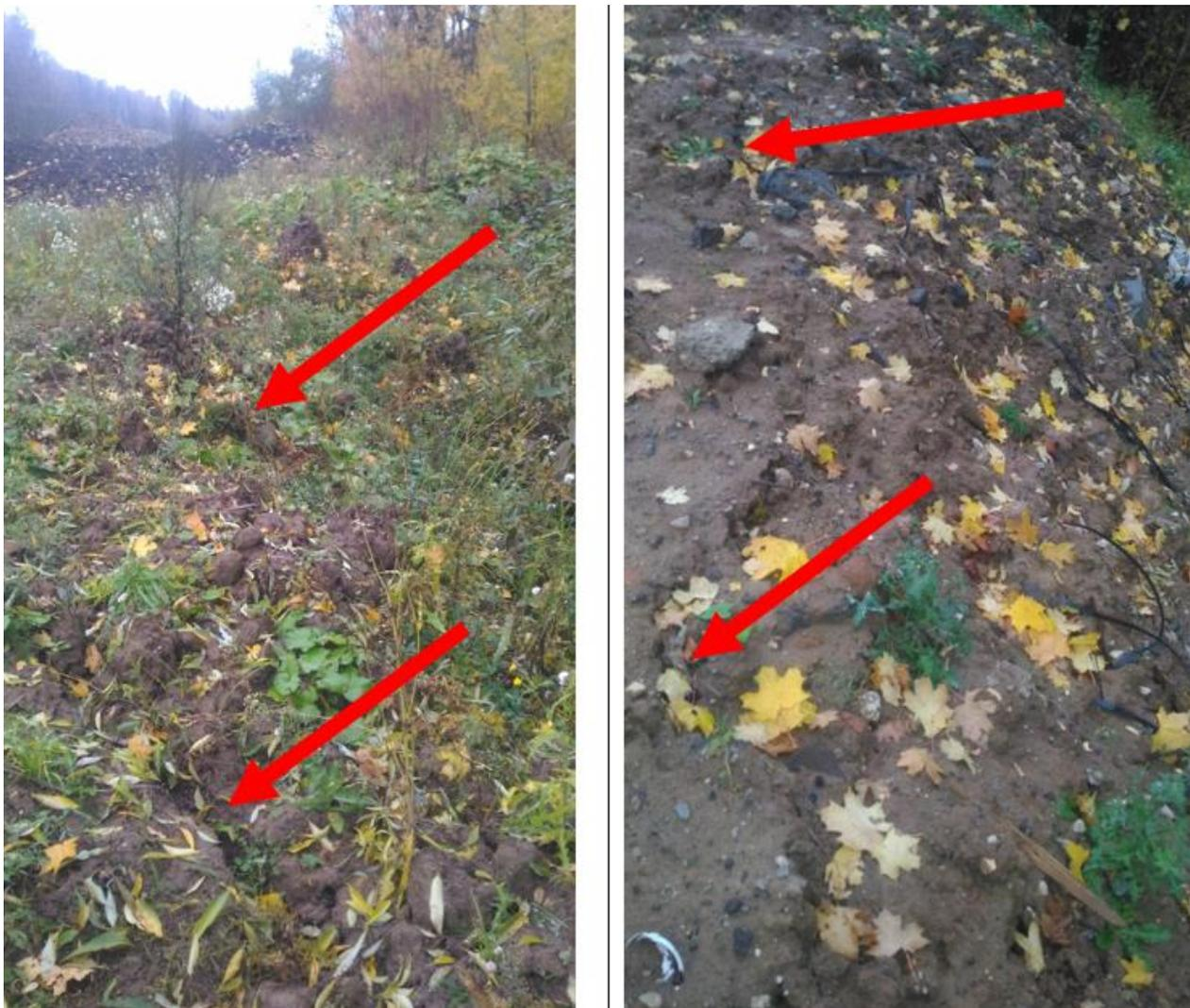
**Рис. 2.** Трещины закола на бровке насыпи
