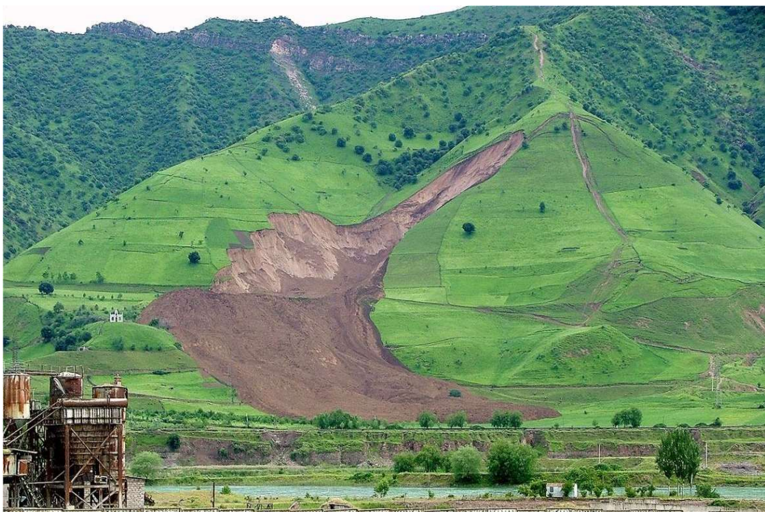
Рисунок 7 Оползень в лёссах в с.Кибил, 2005г. (фото Н.Ицук, 2005г.).
