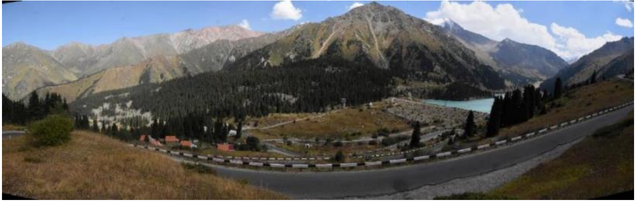
Рис. 3.34. Завальная плотина Большого Алматинского озера. Серые пятна в залесенной части – крупноглыбовые развалы гнейсов
