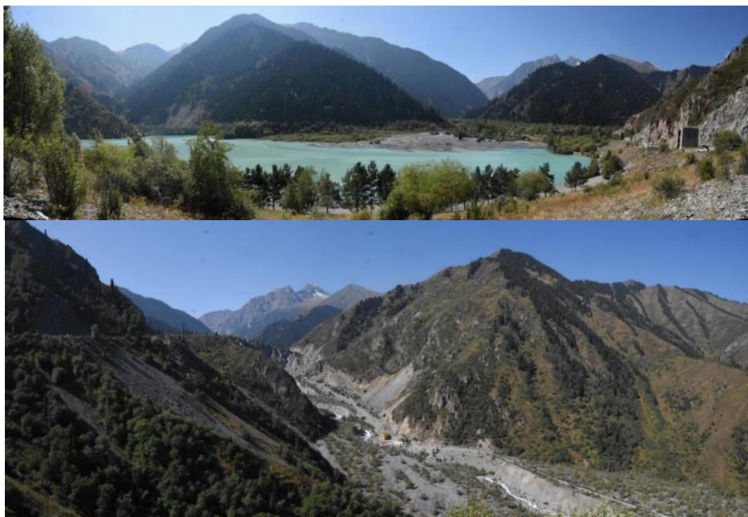
Рис. 1.5. Вверху – вид на озеро Иссык с плотины, построенной после прорыва (хорошо виден конус выноса селя, вытеснившего озеро). Внизу – вид на каньон, промытый в теле завальной плотины и следы прорыва ниже по течению (снимки 2019 г.)
