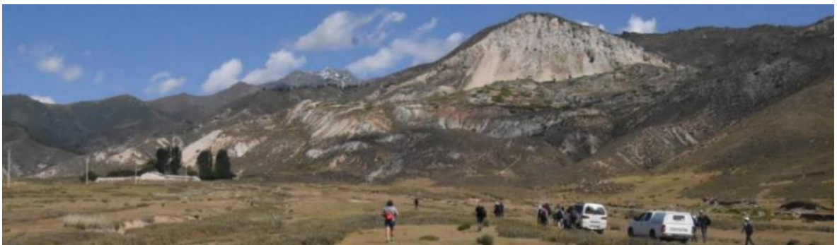
Рис. 1.2. Ананьевский оползень 1911 г. в эпицентральной зоне Кеминского землетрясения (снимок 2019 г.)
