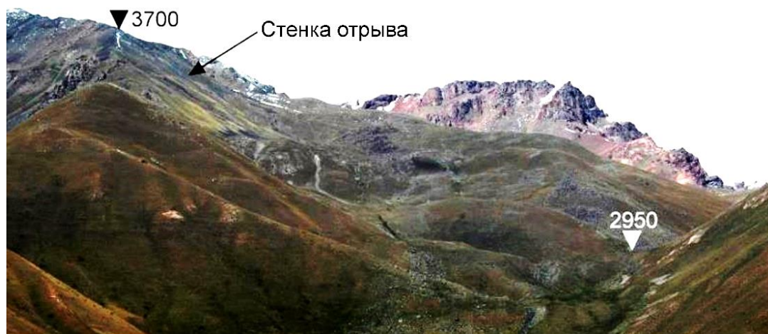
Рис. 7.28. Плоская стенка отрыва каменной лавины Мингтеке. Ее видимое основание перекрыто отложениями тыловой части каменной лавины
