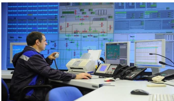
**Рис. 1.** АРМ оператора газового промысла
