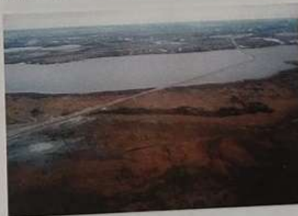
Подтопление дорожной насыпи на пойме между р. Се-Яха и р. Морды-Яха
