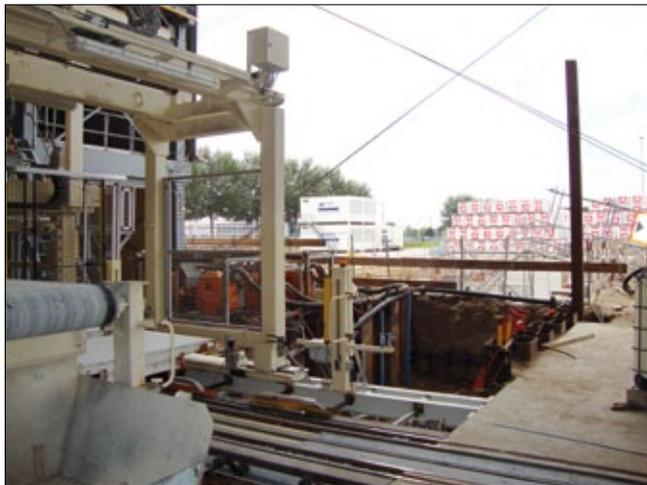
**Рис. 4.** Подготовка новых фундаментов для прессов второго этапа расширения. При этом не требуется остановки производства на уже имеющемся прессе
