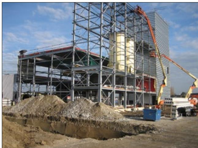
**Рис. 2.** Смесительная установка с двумя реакторами первого этапа строительства. В передней части имеется свободная площадь для последующего расширения производства
