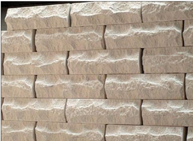
**Рис. 7.** Фрагмент стены из силикатного кирпича, обработанного на WKB-Combi-Embossер. Установка может обрабатывать как природный камень (песчаник, базальт, мрамор), так и искусственный (силикатный, бетонный или керамический кирпич)
