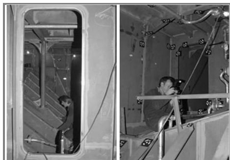
2. ábra: Sarokpontok meghatározása hajótestben [3.]
