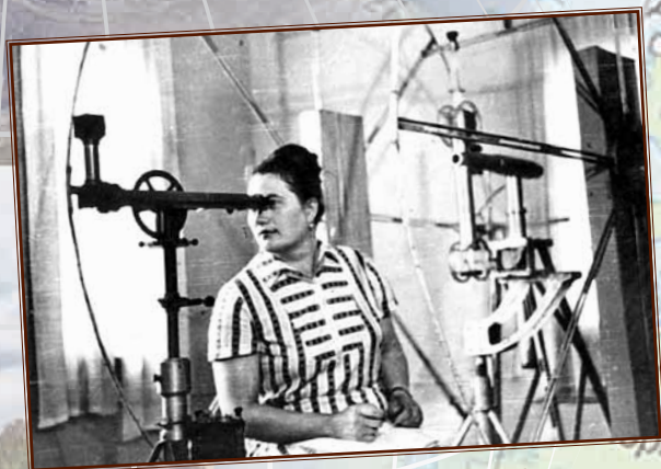
1967 г. Измерение магнитных свойств образцов горных пород на астатическом магнитометре. Геофизик Л.Г. Барковец. Лаборатория ГСЭ
