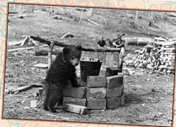
1954 г. ТТГЗ. Дежурный по кухне
