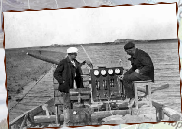
1932 г. В начале 1930-х гг. выдающийся ученый-геофизик А.С. Семенов (Ленинград) проводил уникальные электроразведочные работы для изучения оснований проектируемых гидросооружений, в том числе на р. Енисей
